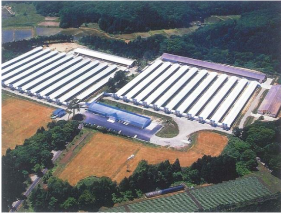
翻新前的 22 栋鸡舍。
